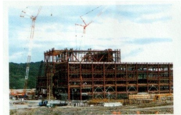
九州電力(株)松浦発電所 ボイラ、ダクト据付工事
