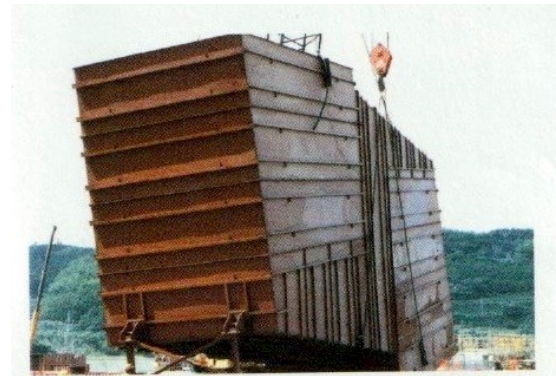
九州電力(株)松浦発電所 ボイラ、ダクト製作工事
